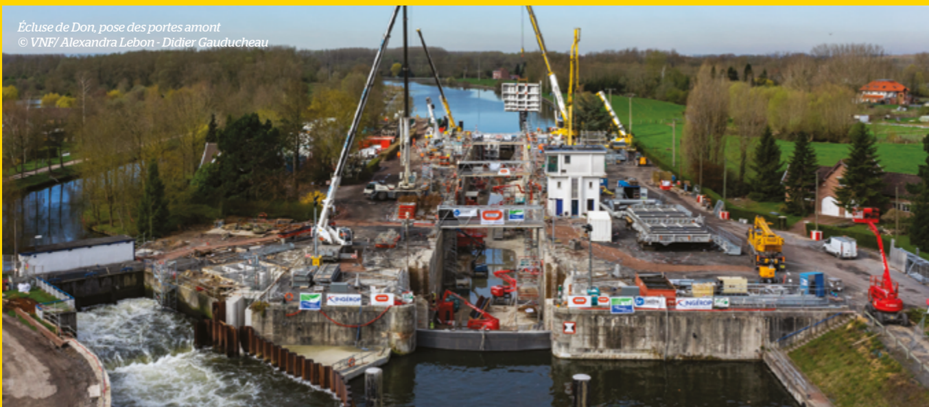
Transbordement sur le Canal Albert © De Vlaamse Waterweg
